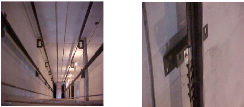
Figura 5. Vista superior de la estructura construida y detalle de la fijación a la viga cajón.
