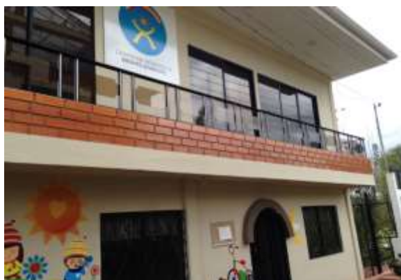
Fachada externa CEIM
