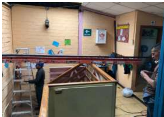
Mejoras en las instalaciones CEIM
