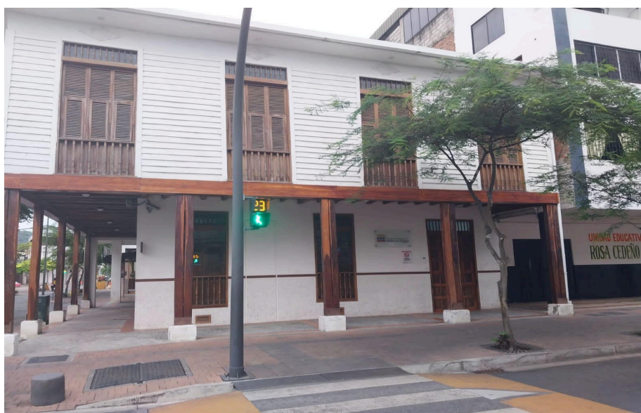
Figura 3. Edificación donde radica la Oficina del Patrimonio en Portoviejo.
