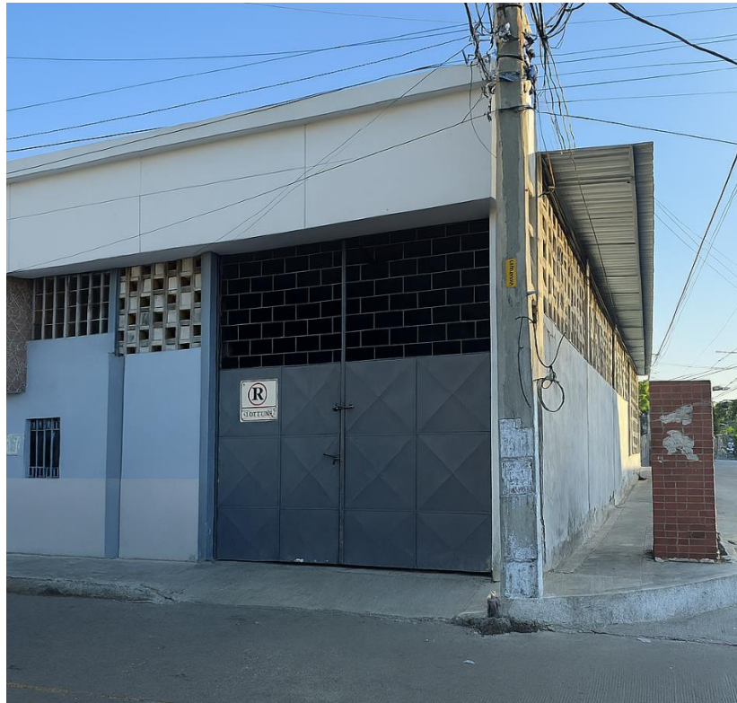
Figura 17. Instalaciones de la empresa metalmecánica en estudio.
